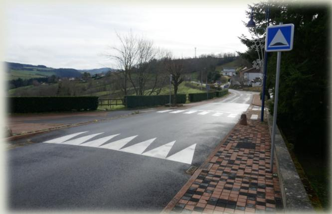
Les travaux de rénovation du carrefour, la mise en place de ralentisseurs ainsi que la mise aux normes des trottoirs (PMR), se sont terminés fin 2019
